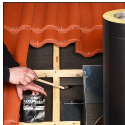
Se till att takpappen ligger över underbeslaget på plåtdelen motnock. Använd takpappsklister eller likvärdig produkt.
